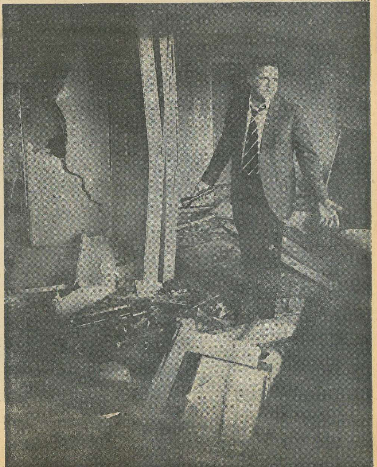
O embaixador de Cuba, Astray Rodrigues, percorre as instalações da chancelaria destruídas por uma forte carga explosiva
