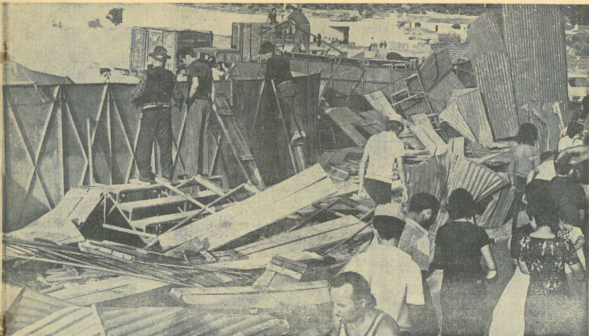
À estrutura metálica da Praça da Amareieja ruu em poucos segundos. Um pesado momento de confusão marcou a tragédia que custou a vida de três pessoas
